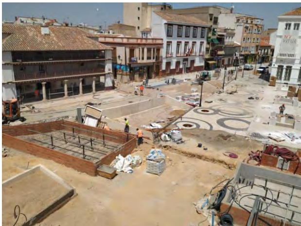
Obras en la Plaza de España
